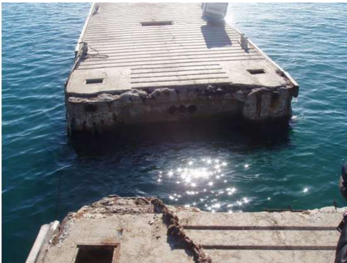
Φωτογραφία 1: Αποσυνδεδεμένος πλωτός προβλήτας (κοντινή λήψη)
